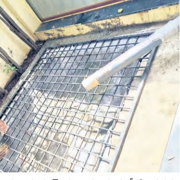
చారు. భవిష్యత్ తరాలకు తగిన నీటి భద్రతను కల్పించాలనే ప్రతిపాదన వద్ద పు నీటి సరఫరాలో భాగస్వామి కావాలని ఆయన కోరారు.
